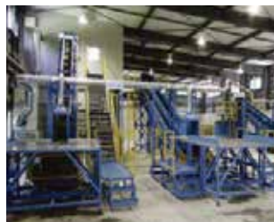
第3工場(リサイクル施設)
