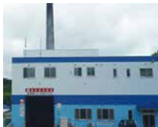
第1工場(焼却施設)
