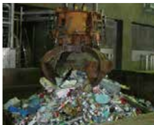
第2工場(破碎施設)
